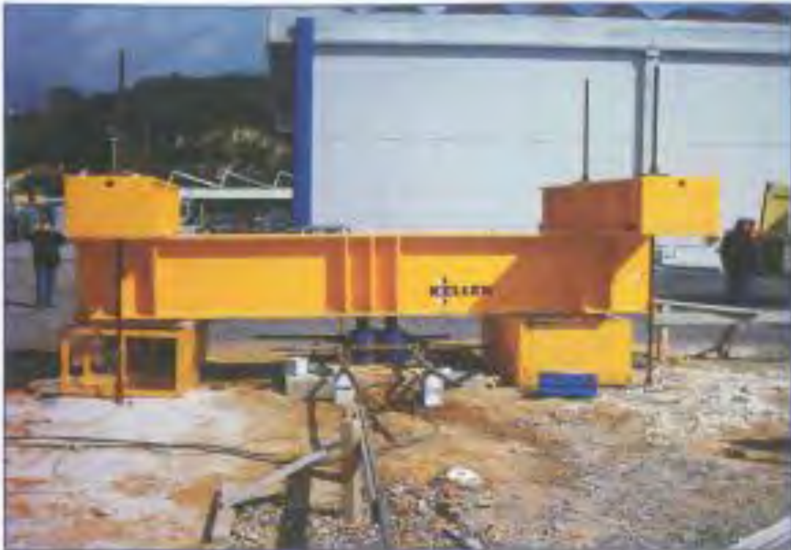
PROVA CON ANCORAGGIO A 4 PALI IN TRAZIONE
