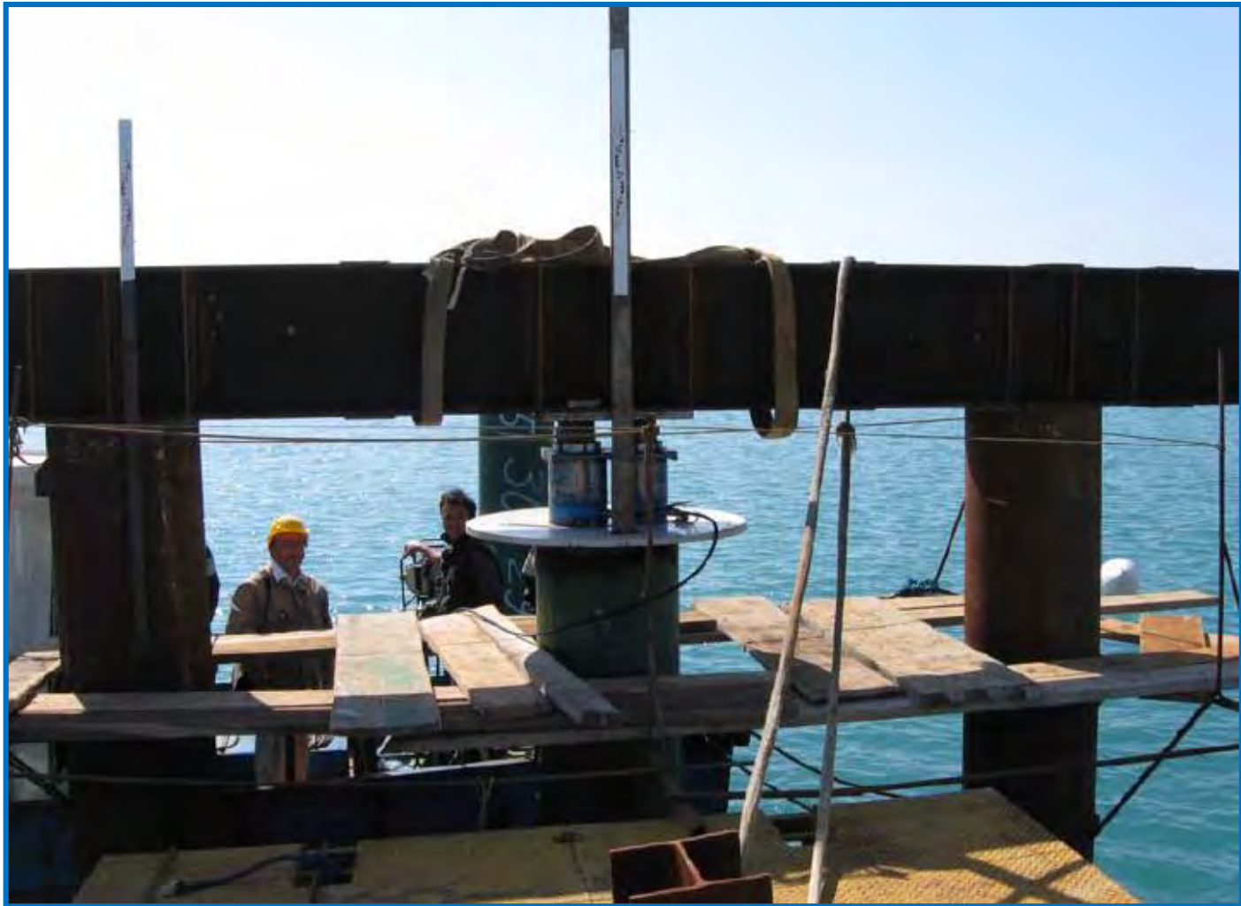
Allestimento della Prova di Carico
