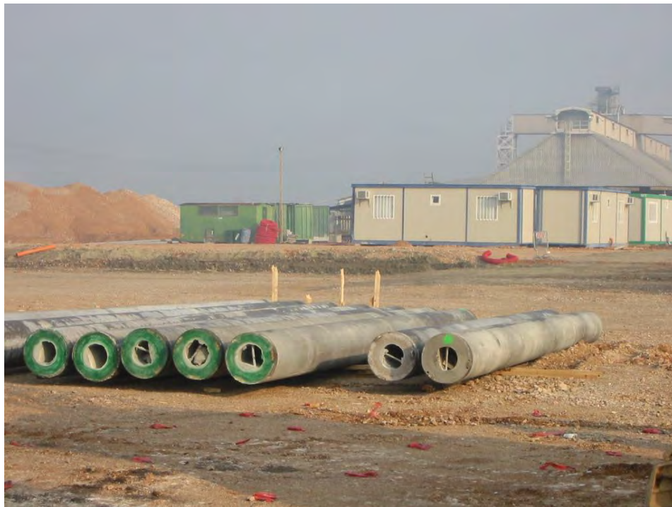
Pali prefabbricati in calcestruzzo Silos Clinker – Porto di Ravenna
