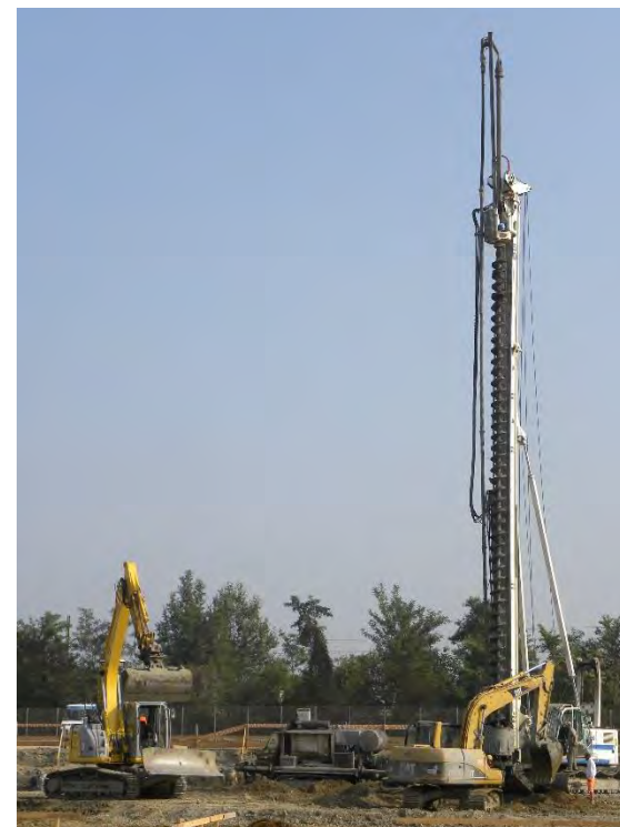
Capannone Industriale (Ravenna) Pali CFA
