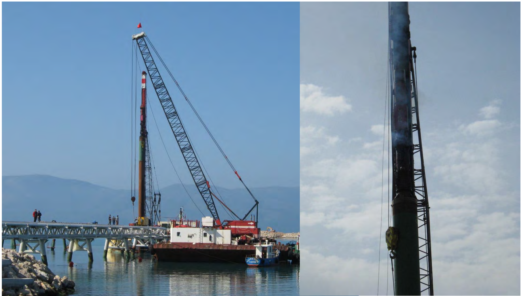
Pontile Impianto Petrolifero Pali in acciaio infissi con maglio diesel
