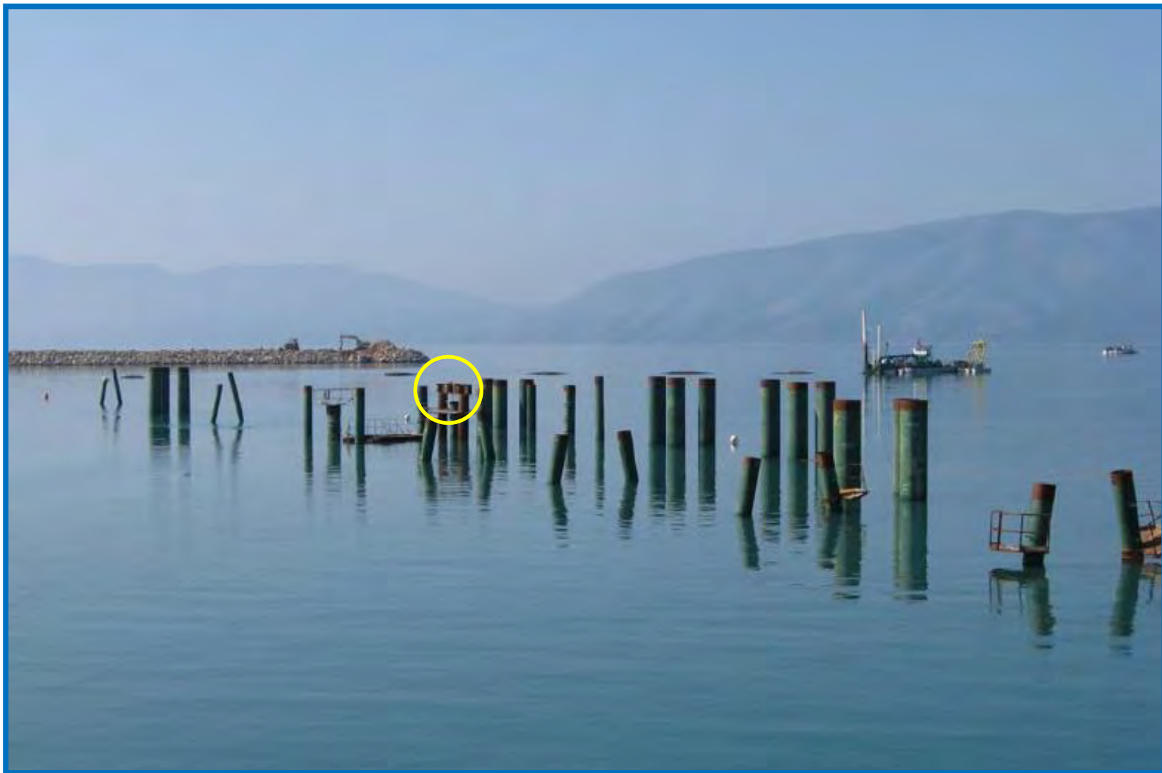
Vista dei pali del pontile, della piattaforma e delle briccole
