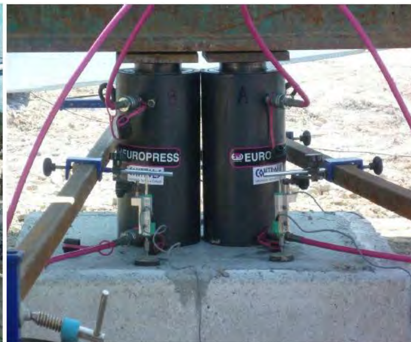
Particolare del martinetto di carico e del sistema di lettura dei cedimenti.
